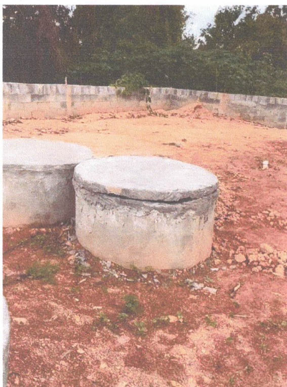
Tampas de alvenaria danificadas
