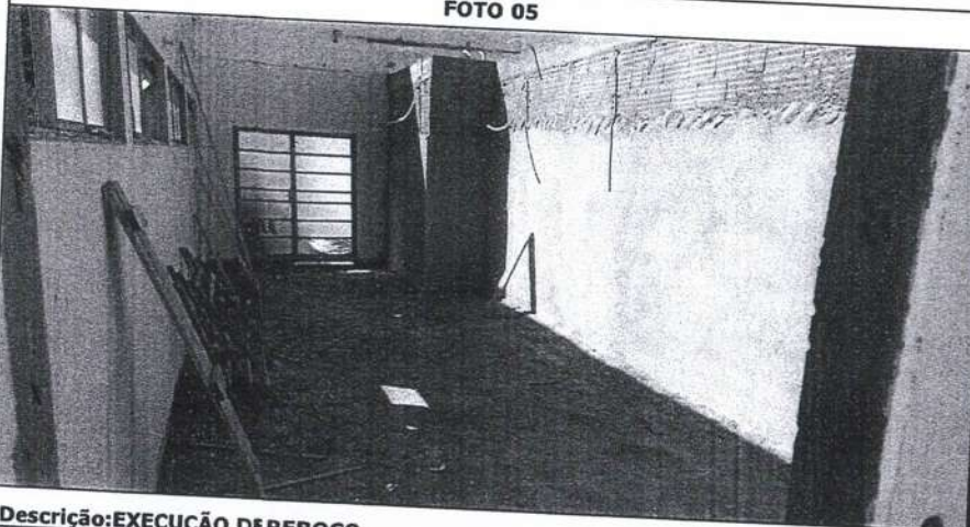
Descrição: EXECUÇÃO DE REBOCO.
