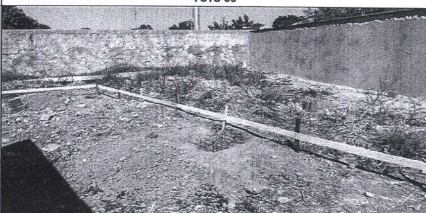
Descrição: EXECUÇÃO DE GABARITO E MURO DIVISORIO.
