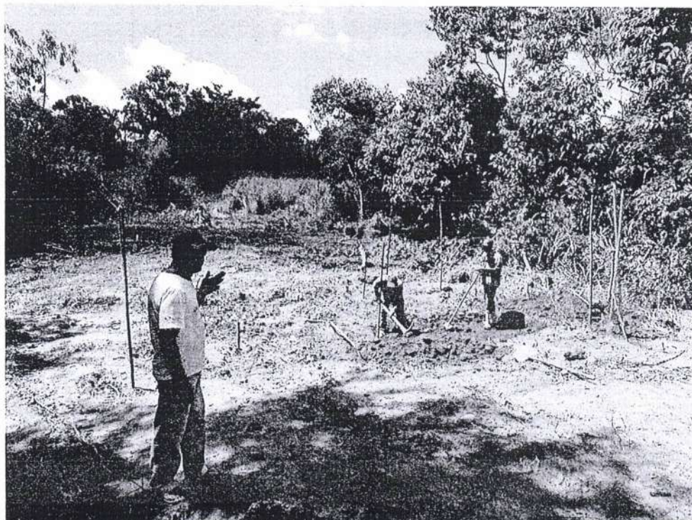
FOTO 01: INÍCIO DA OBRA.
