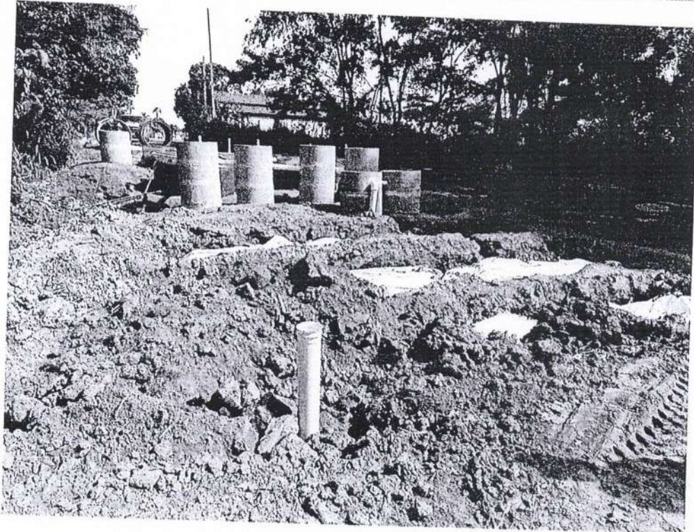
FOTO 04: DRENOS ECOLÓGICOS INSTALADOS.
