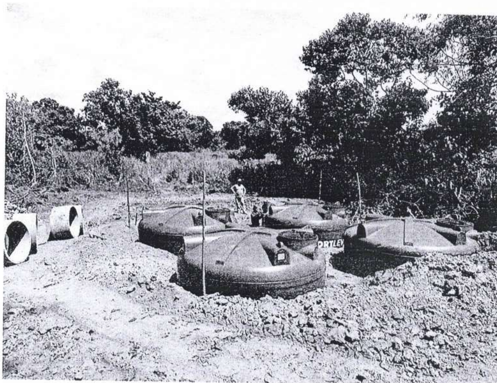
FOTO 02: INSTALANDO OS REATORES.
