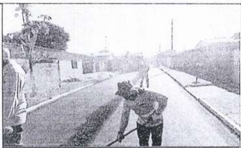
Capa asfáltica - Rua Adelino Pereira Passos
