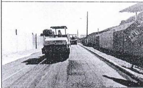
Capa asfáltica - Rua Sebastião Arlindo
