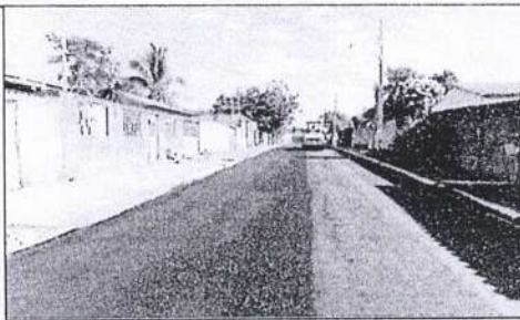
Capa asfáltica - Rua Lázaro Nunes Silva
