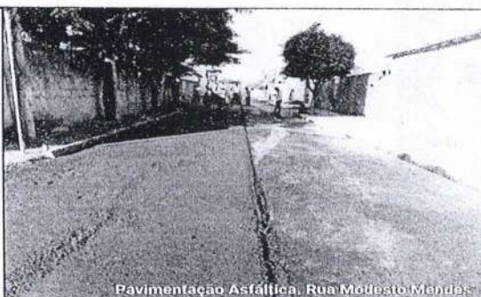
Pavimentação Asfáltica, Rua Modesto Mendes
