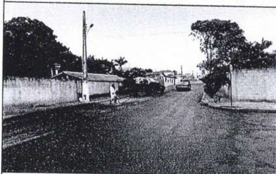
Recapeamento asfáltico - Rua Fróis
