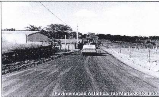
Pavimentação Asfáltica: rua Maria do Rosario
