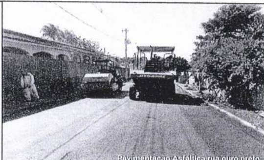
Pavimentação Asfáltica rua ouro preto
