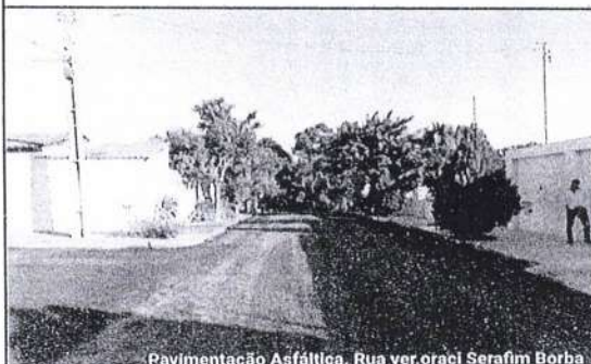
Pavimentação Asfáltica, Rua vereador Oraci Serafim Borba
