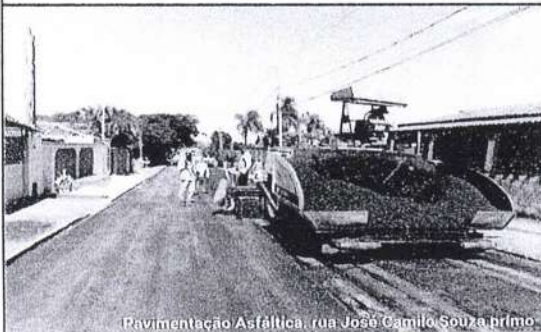
Pavimentação Asfáltica: rua Jose Camilo Souza Primo
