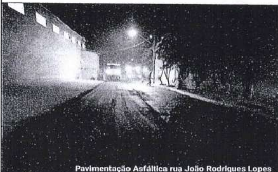
Pavimentação Asfáltica rua João Rodrigues Lopes
