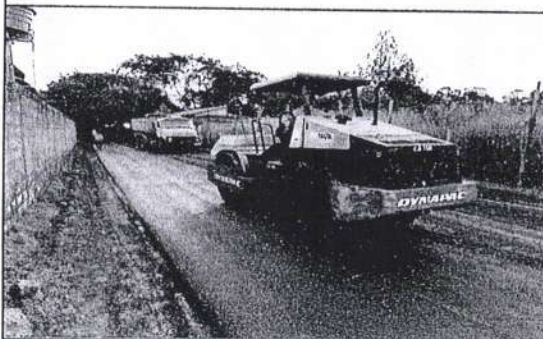
Recapeamento asfáltico - Rua Fróis
