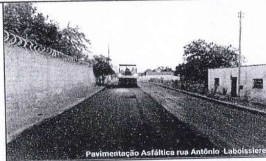
Recapeamento asfáltico - Rua Antonio Laboissiere
