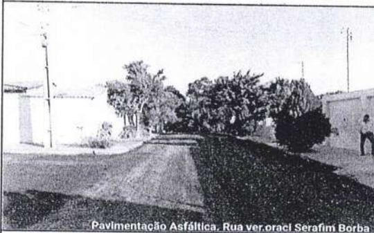
Pavimentação Asfáltica: Rua vereador Oraci Serafim Borba
