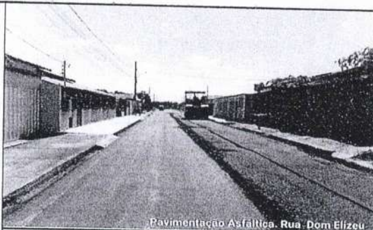
Recapeamento asfáltico - Rua Dom Elizeu
