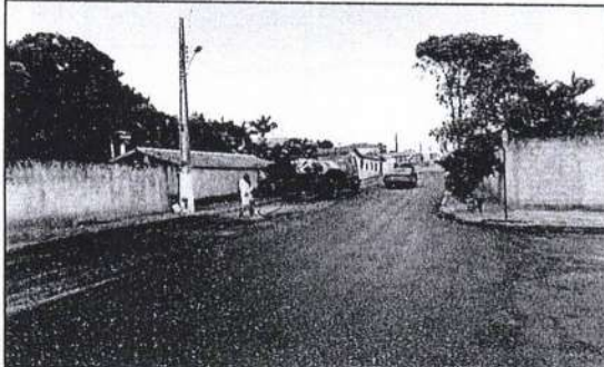
Recapeamento asfáltico - Rua Fróis
