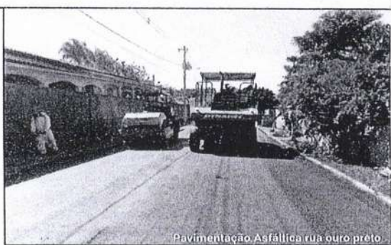
Pavimentação Asfáltica rua ouro preto
