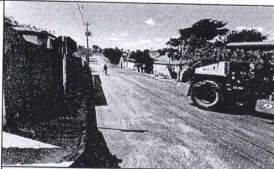
Recapeamento asfáltico - Rua Ouro Preto
