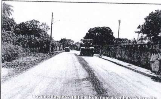
Recapeamento asfáltico - Rua Nossa Senhora Aparecida
