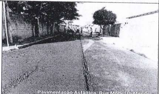
Pavimentação Asfáltica: Rua Modesto Mendes
