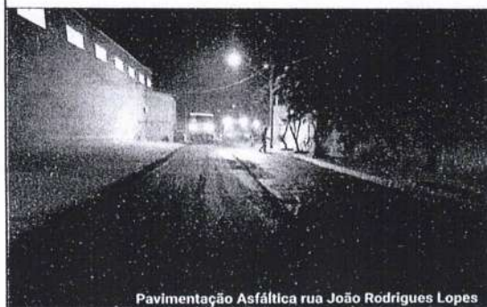
Pavimentação Asfáltica rua João Rodrigues Lopes
