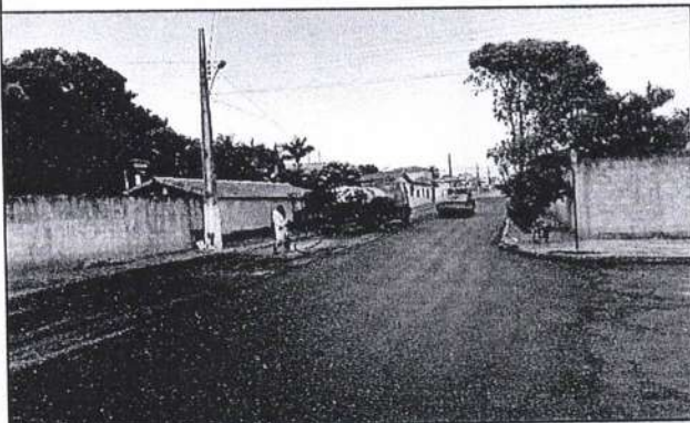
Recapeamento asfáltico - Rua Fróis
