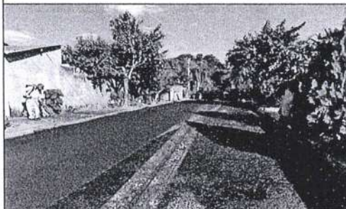
Recapeamento asfáltico - Rua Oraci
