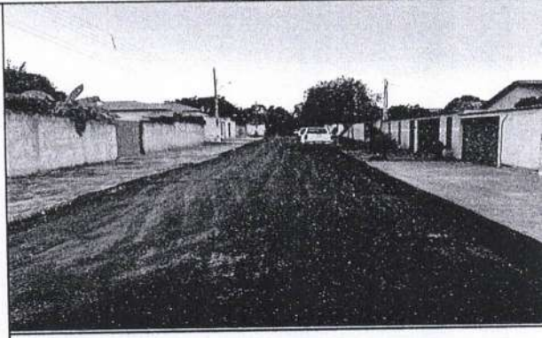
Recapeamento asfáltico - Rua Vereador Serafim Borba
