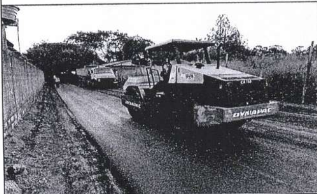
Recapeamento asfáltico - Rua Fróis
