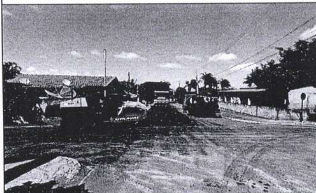
Recapeamento asfáltico - Rua Jose Camilo de Souza Primo
