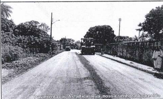
Recapeamento asfáltico - Rua Nossa Senhora Aparecida
