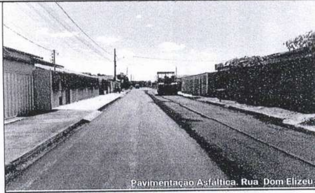
Recapeamento asfáltico - Rua Dom Elizeu
